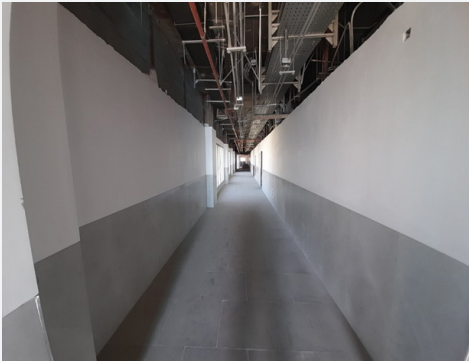
▲ راهرو واقع در ساختمان ۳
