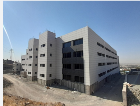
▲ نمای ضلع شمال و غرب پروژه
