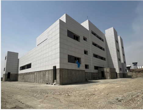
▲ نمای ضلع شمالی و شرقی پروژه
