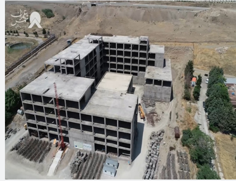
▲ نمای کلی اسکلت پروژه
